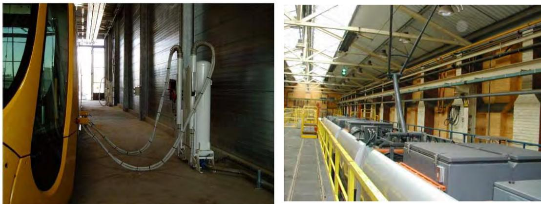
**Figure 1 : Distributeur de sable et passerelle fixe**
